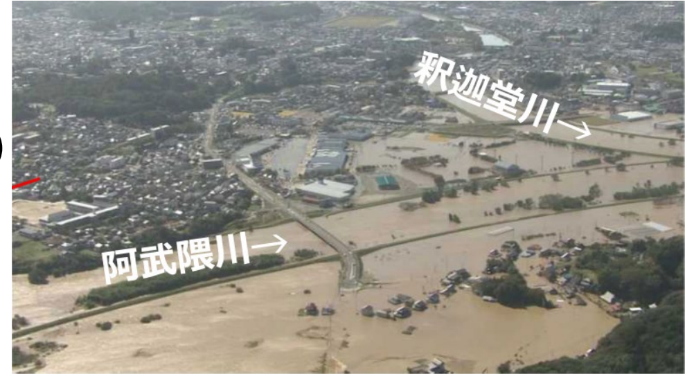
阿武隈川氾濫 (令和元年東日本台風) 国交省
