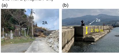
写真 A2. 石川県の輪島港 (調査地点番号: 2) の測定点とその周辺の様子. (a) 測定点 2A. 2024 年能登 半島地震に伴う土砂崩れで輪島験潮場は亡失した (国土地理院, 2024b). (b) 測定点 2a. 防波堤の上部 を構成するブロックの高さ (黄色の矢印) を測定した.
