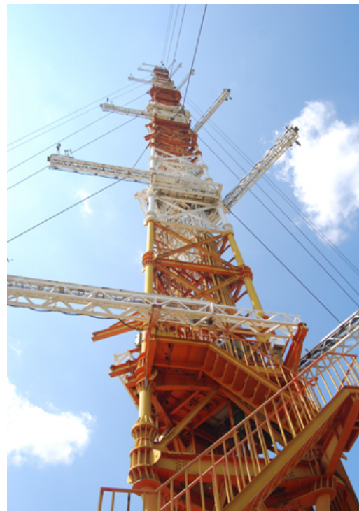
第1図 地上から見上げた気象観測鉄塔。6つの高さから3方向にアームが伸びている。
