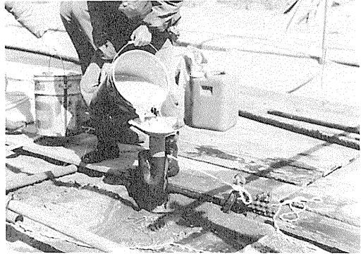
写真 4.3 ペントナイトの注入 Photo. 4.3 Shore earth work.
