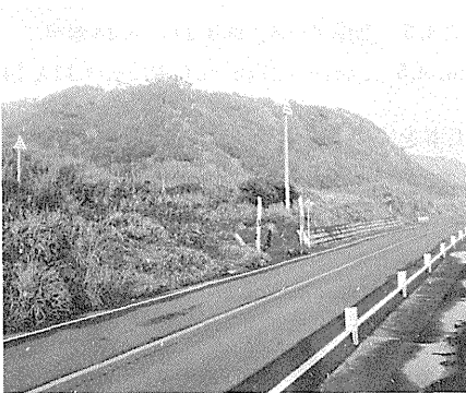
写真4.6 ケーブル標識柱
