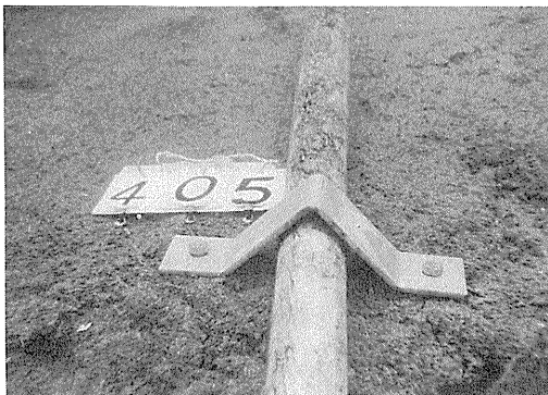
写真 3.28 ケーブルの固定
