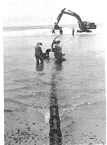
写真 3.26 ケーブルの防護工事
