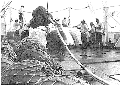
写真3.23 ケーブルの陸揚
