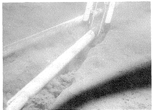
写真 3.27 ケーブルの防護工事
