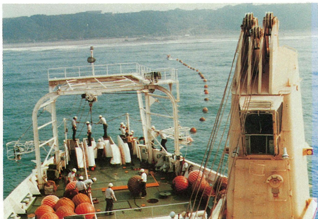
写真 5 海底ケーブル陸揚げ工事 Photo. 5 Landing of the submarine cable
