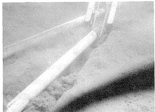
写真 3.27 ケーブルの防護工事
