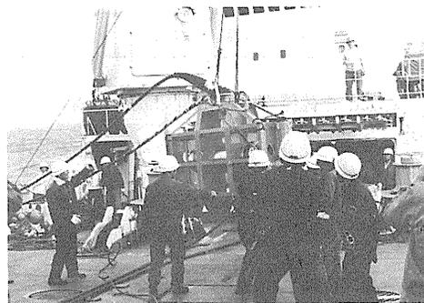
写真3.6 先端装置布設リハーサル
