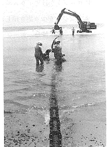
写真 3.26 ケーブルの防護工事
