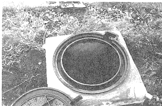
図3.4.6 R点観測坑の外観
