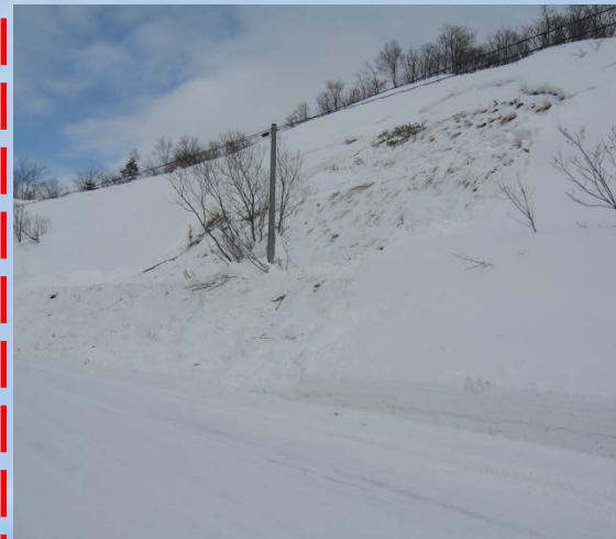
2006年1月北海道幌延町に おける道路沿いの雪崩
